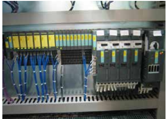
图 22 安全控制柜通过PROFI-safe实现安全通信
